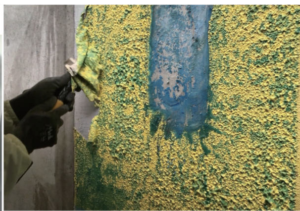
左:「AGバブルシステム」泡の噴出状況。きれいな泡を吐き出し、粉塵を含んだ泡を吸い込む。右:「AGリムーバー」アスベストを含む既存塗膜仕上げ材を軟化・膨潤させて除去する剥離剤
