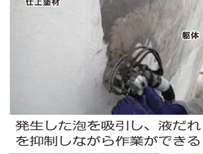
泡で湿潤し、粉塵の飛散を防止しながら下調整材と仕上げ塗材を同時に除去
