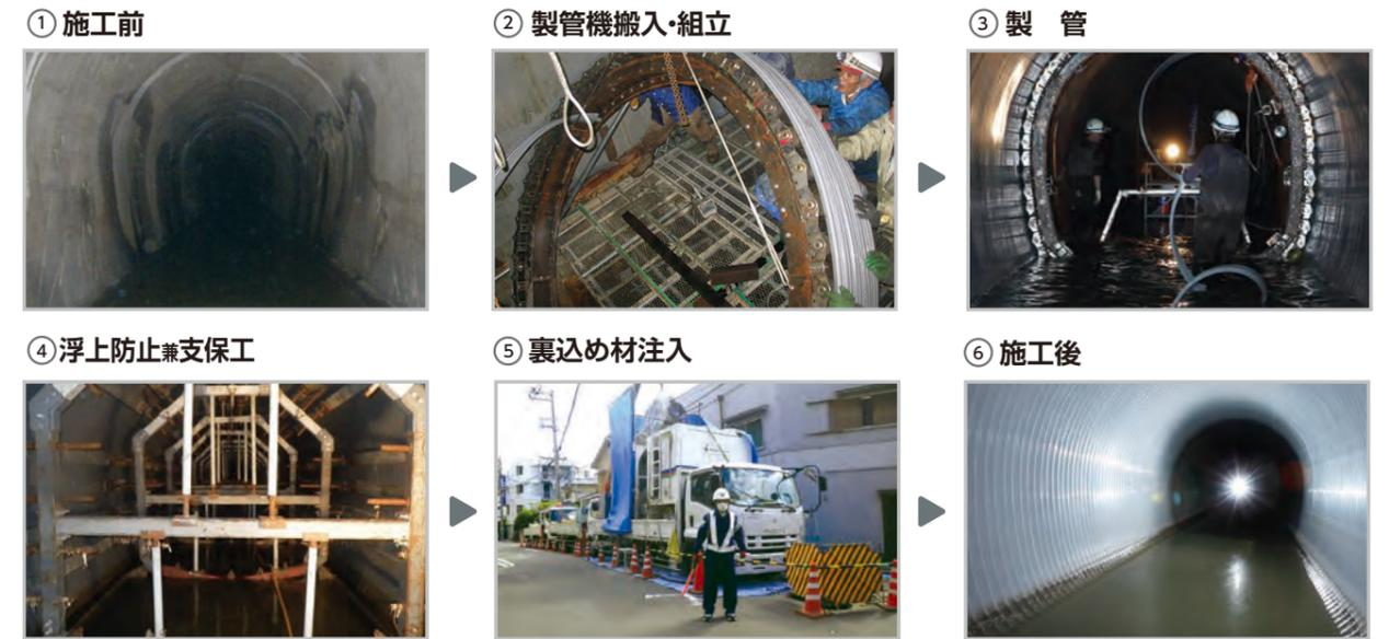
プロフィールを既設マンホールから製管機に供給。製管機は既設管内で回転しながら製管していきます。
