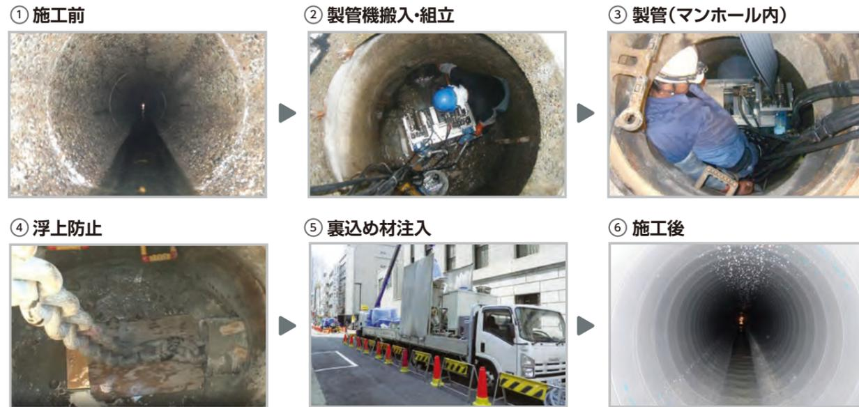
プロフィールを既設マンホールから製管機に供給。マンホール内に設置した製管機にプロフィールを押し込むことにより、既設管内に製管していきます。
