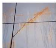
目視調査(外壁調査)
