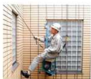
目視調査(外観調査)
