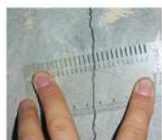
目視調査(ひび割れ調査)
