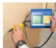
鉄筋位置、かぶり厚さ測定
