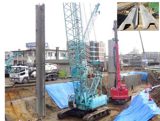
愛知県豊田市：調整池築造工事（波形コンクリート矢板建込）
