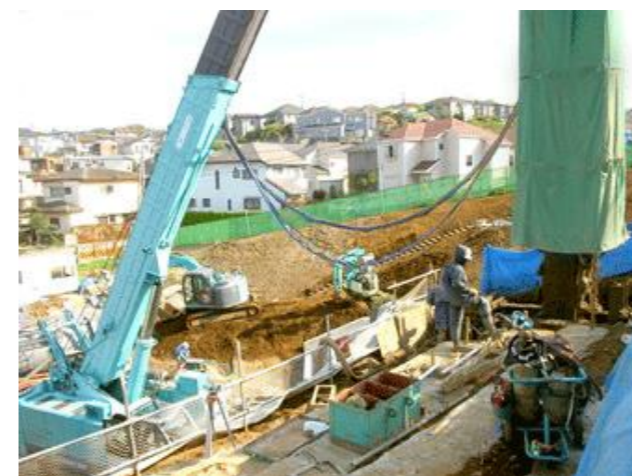
施工機位置と施工箇所の高差6m、作業半径約10mで施工
