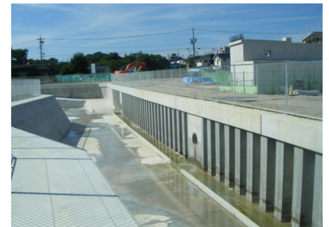
愛知県豊田市：調整池築造工事（波形コンクリート矢板建込）
