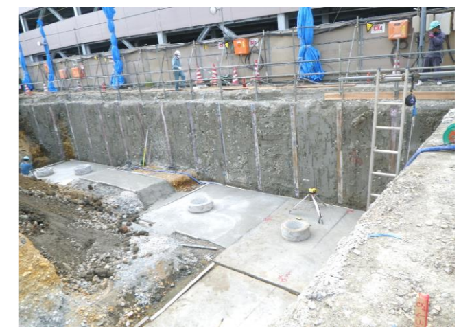
金沢市：土留止水壁施工完了後 掘削状況
