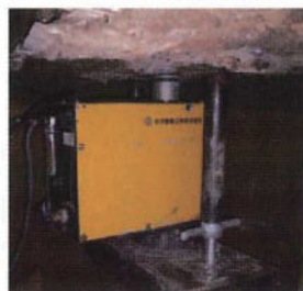
■ 自動ジャッキ設置状況
