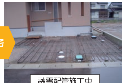
融雪配管施工中
