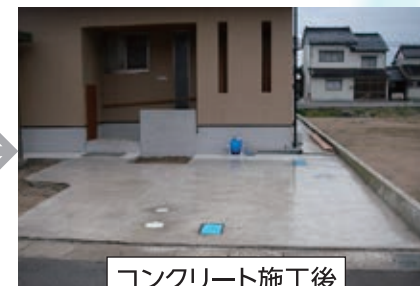
コンクリート施工後
