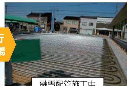
融雪配管施工中
