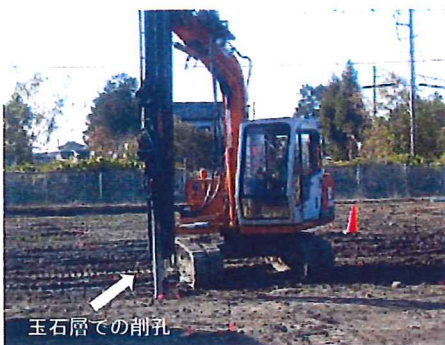
②支柱鋼管回転圧入
