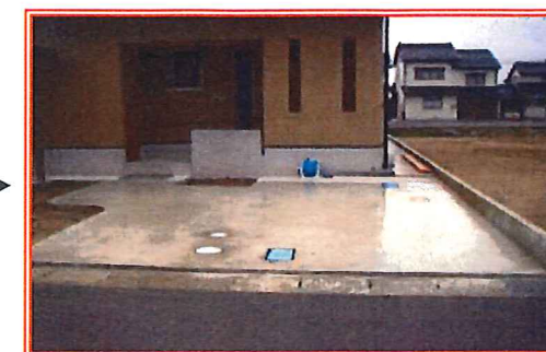
(コンクリート施工後)
