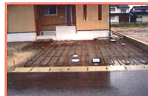
(融雪配管施工中)
