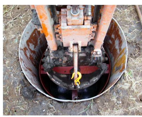
所定深度に達したら内部清掃、底盤まで泥土除去
