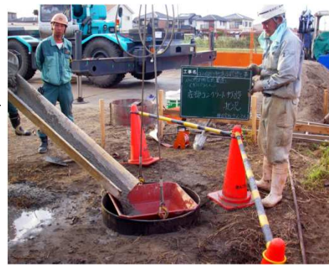
特殊トレミー管にて底盤コンクリート打設(水中コンクリート)
