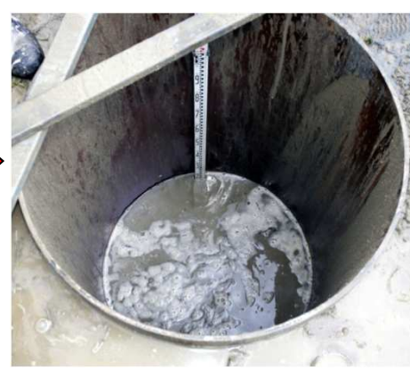
コンクリート固化後・高さ調整
