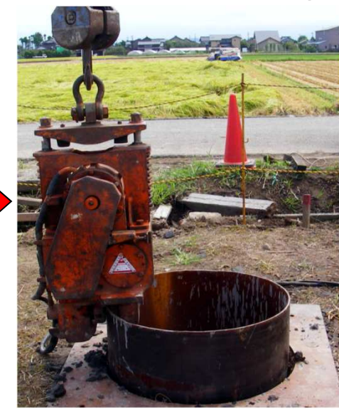
再びバイブロハンマーにて打込
