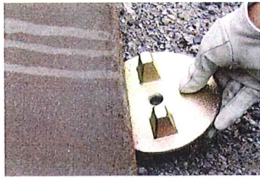
1.リンクプレート下部を敷鉄板に挿入します。
