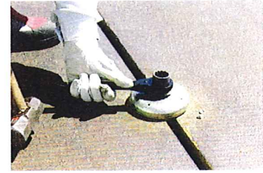
6.再度センターボルトの本締めを行います。
