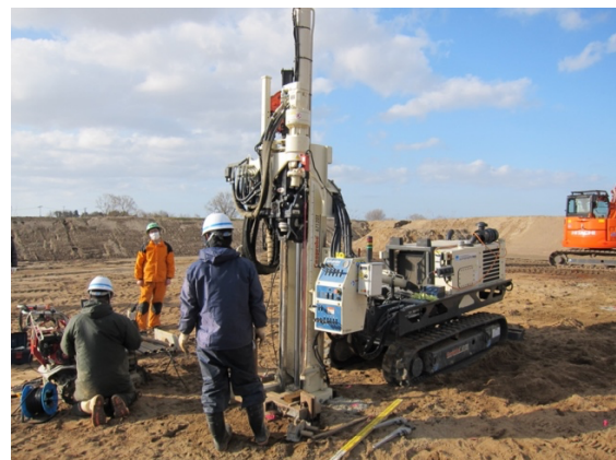
写真-5.2 3成分コーン貫入試験
