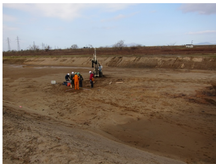
図-5.3 横場新田地区河道（河川敷）掘削地
