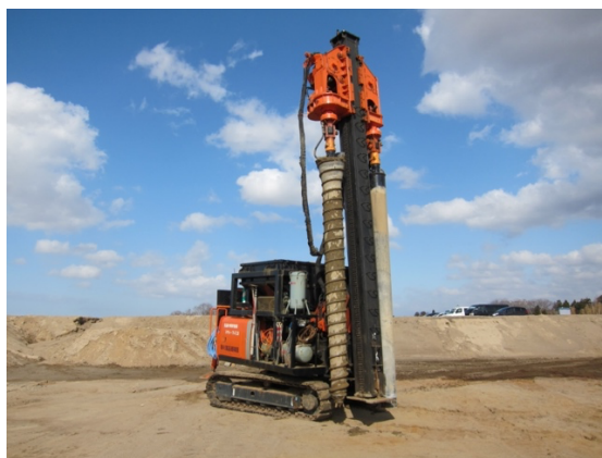
写真-5.1 グラベル・パイルの施工
