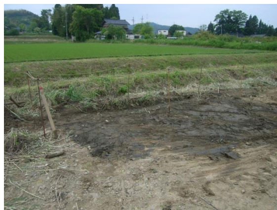
〔埋設完了状況〕
