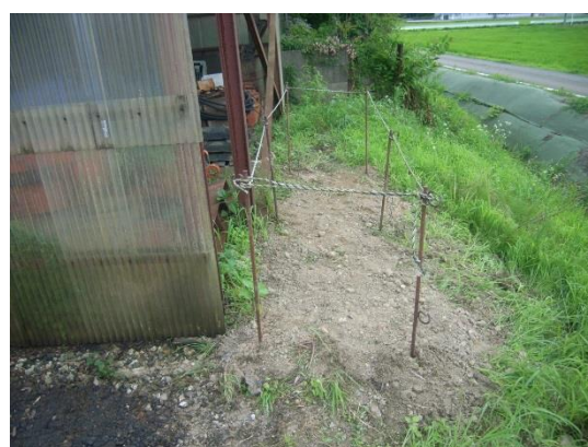
〔埋設完了状況〕
