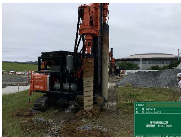
(b) 圧密掘削状況
