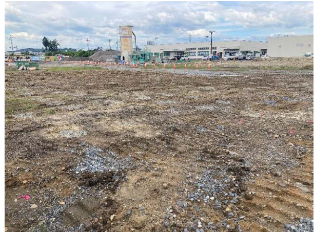
(l) 工事完了 2
