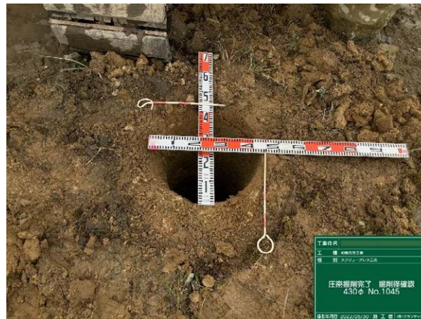
(f) 掘削孔確認
