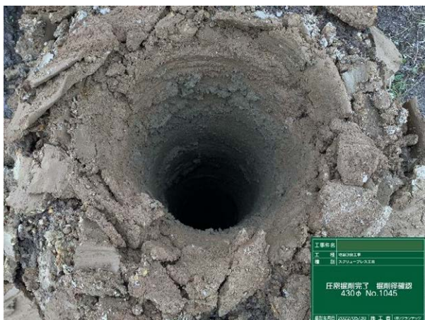
(e) 掘削孔確認
