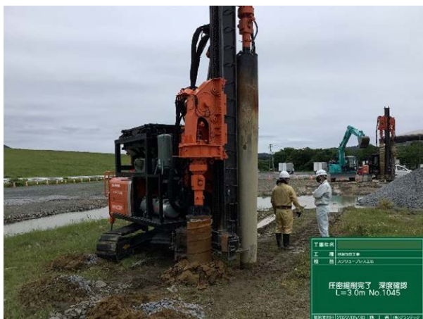
(c) 圧密掘削完了
