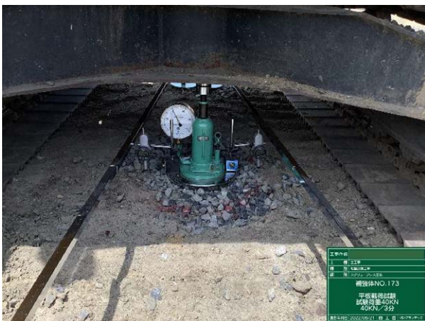
写真2 簡易載荷試験
