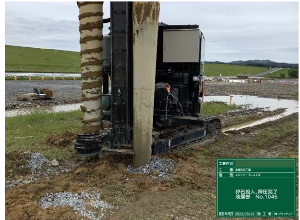
(h) 砕石投入押圧完了
