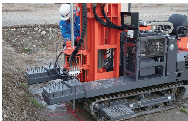
写真4. 杭芯の確認状況
