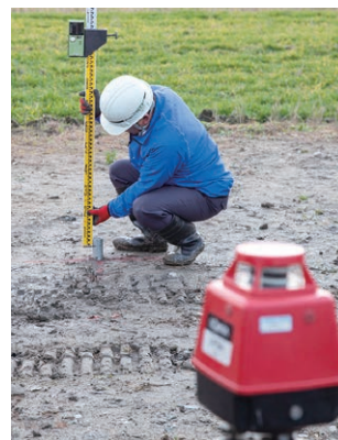
写真7. 杭頭高さの確認状況
