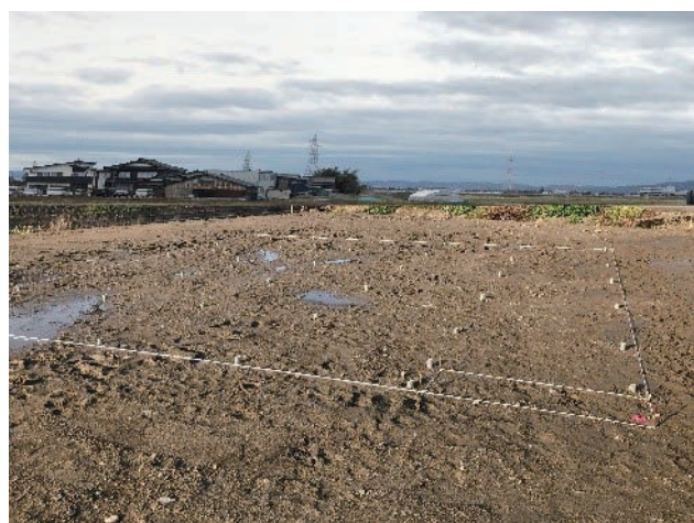
写真8. 施工完了時の状況
