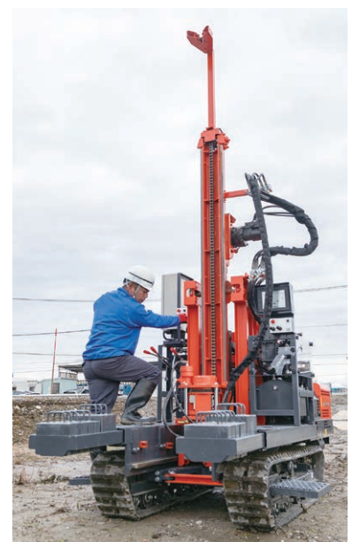
写真 3. 専用施工機および資材の搬入状況
