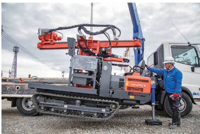
写真 2. 専用施工機および資材の搬入状況
