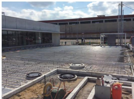
写真 1. 無散水融雪配管工事状況
