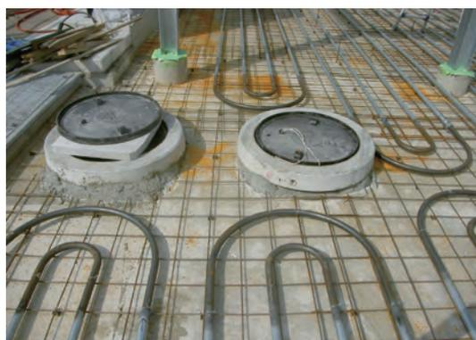
写真3. リターンバンド配管状況
