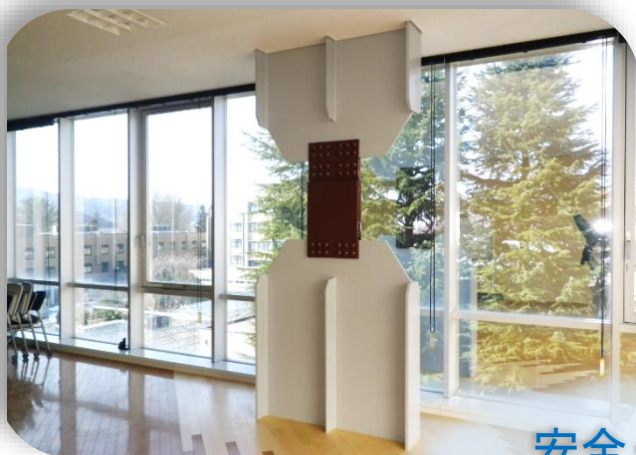
制震補強 VESダンパー工法
