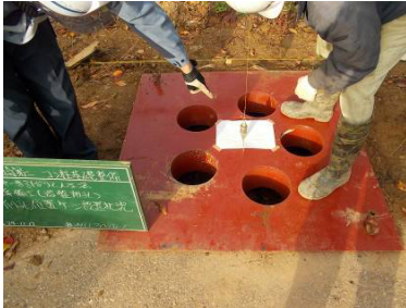
<ガイドプレート設置・芯出し>
