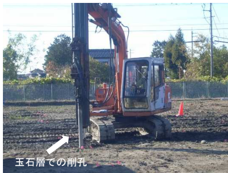
② 支柱鋼管回転圧入
