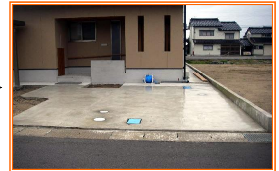
(コンクリート施工後)
