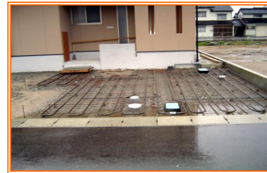
(融雪配管施工中)
