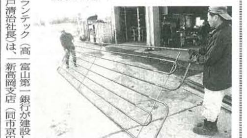
富山第一銀行新高岡支店前の歩道に施工する無散水融雪システムのパイプ
